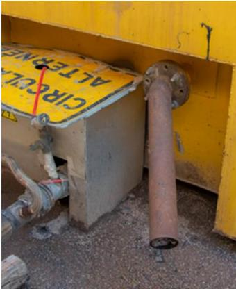
La citerne dispose d'un évent garantissant la mise à la pression atmosphérique du ciel gazeux. Elle dispose également d'une canalisation de décharge permettant d'éviter le débordement. Cette vidange est constituée d'une canalisation de 80 mm se déversant dans la cuvette. ***L'obturation a été réalisée au moyen d'un chiffon humide.***
